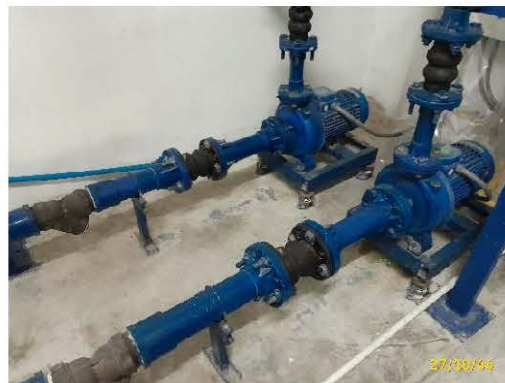
เครื่องสูบน้ำ และ Booster pump
