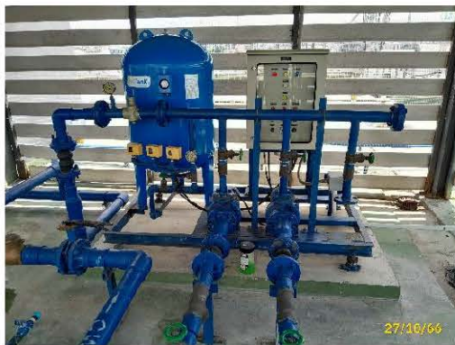
เครื่องสูบน้ำ และ Booster pump
